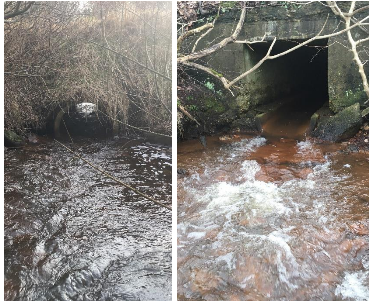
Figur 3-10. Vandløbsbunden kan med fordel hæves ved udlægning af sten/grus neden for rørbroen i Brogård Bæks station 3.099 (t.v.) for at reducere vandhastigheden og lette passage for svage svømmere. Det samme gælder ved den gl. jernbanebro i bækkens station 1.296 (t.h.).
