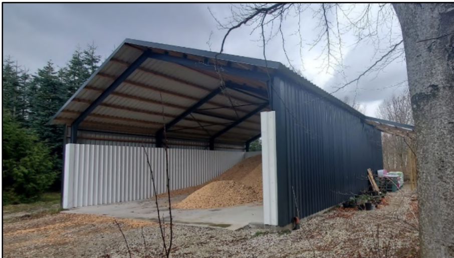
Foto af udhuset til brænde og flis
